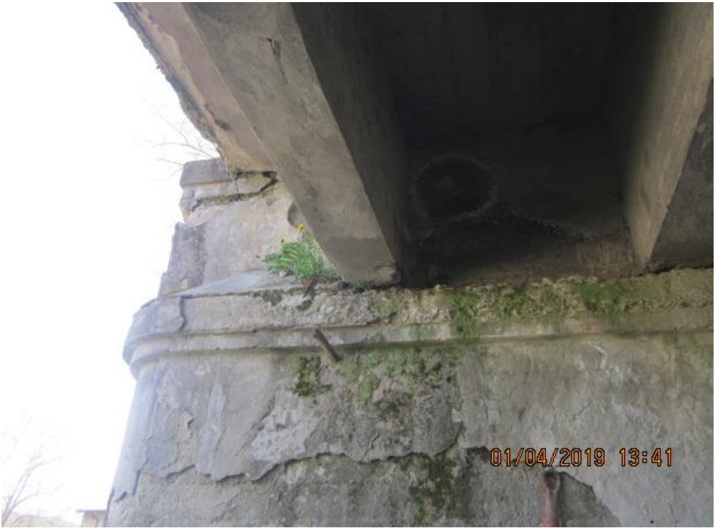
SPALLA SX LATO VALLE
