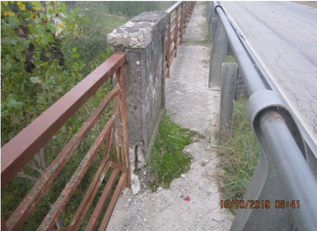
PARAPETTI E MARCIAPIEDE
