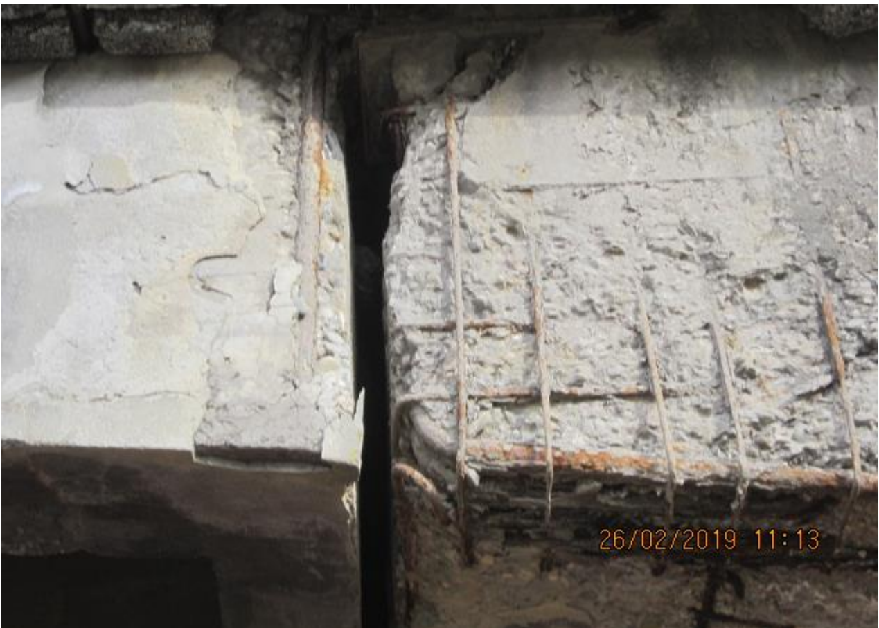
Degrado gerber
