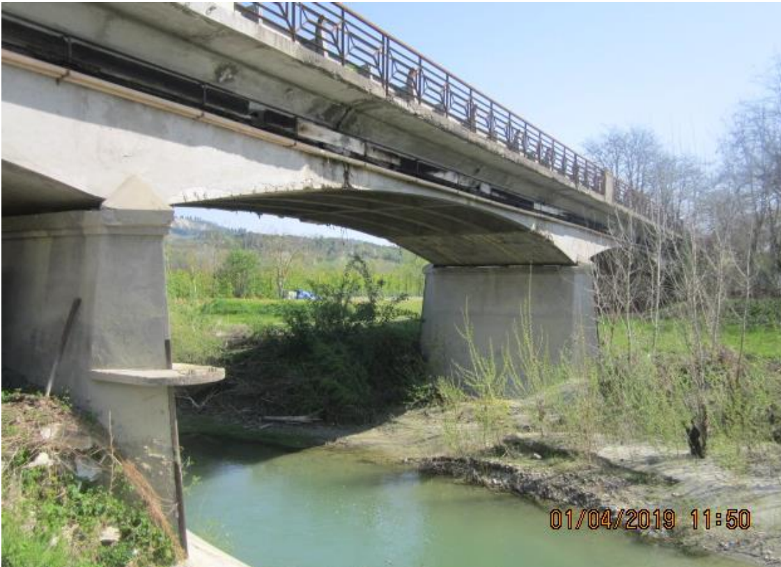
PILE 2 E 3 SUL SENIO
