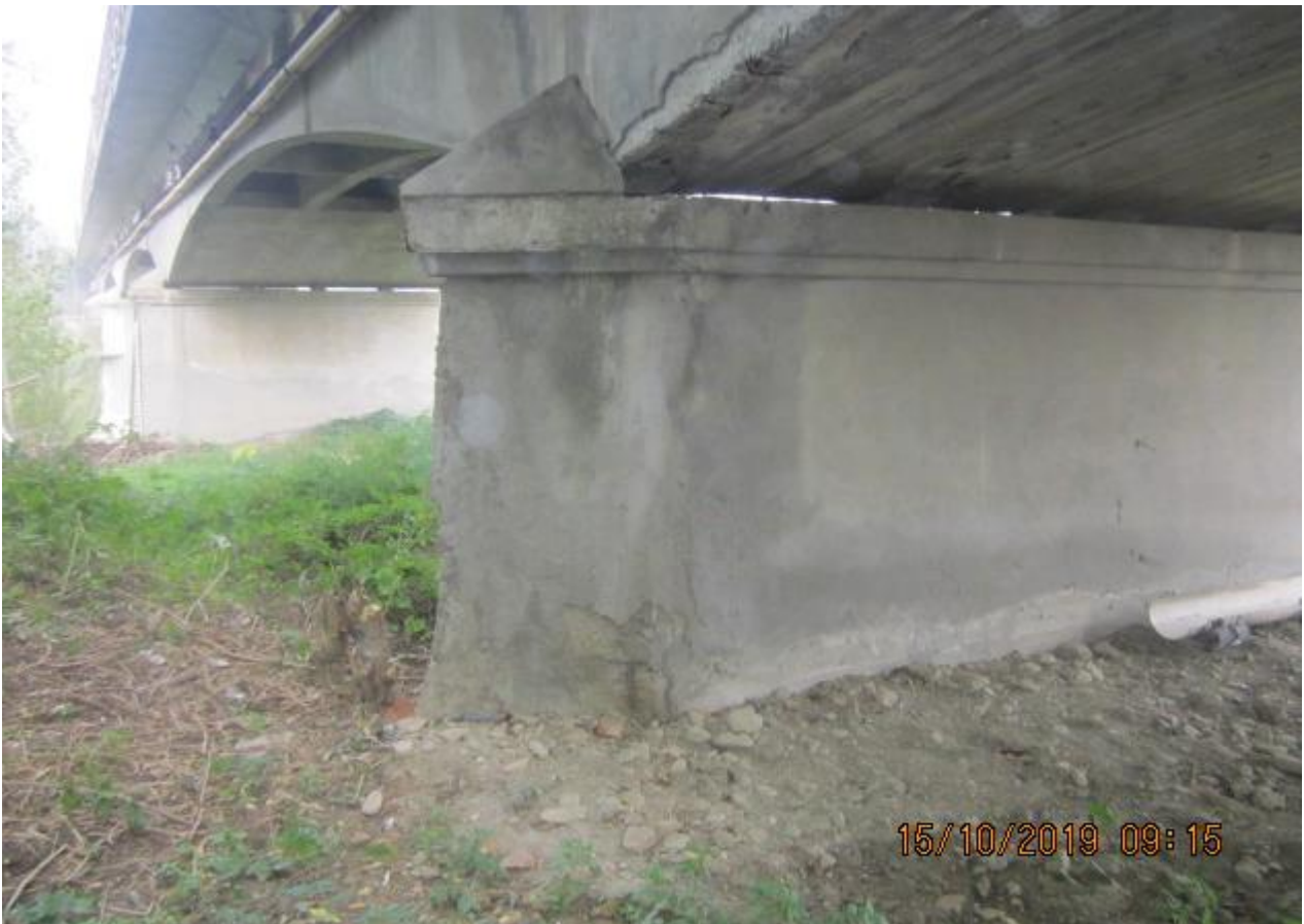
PILA 'CORTA' ( QUI LA NR. 1 ) LA PILA 4 E' ANALOGA.
