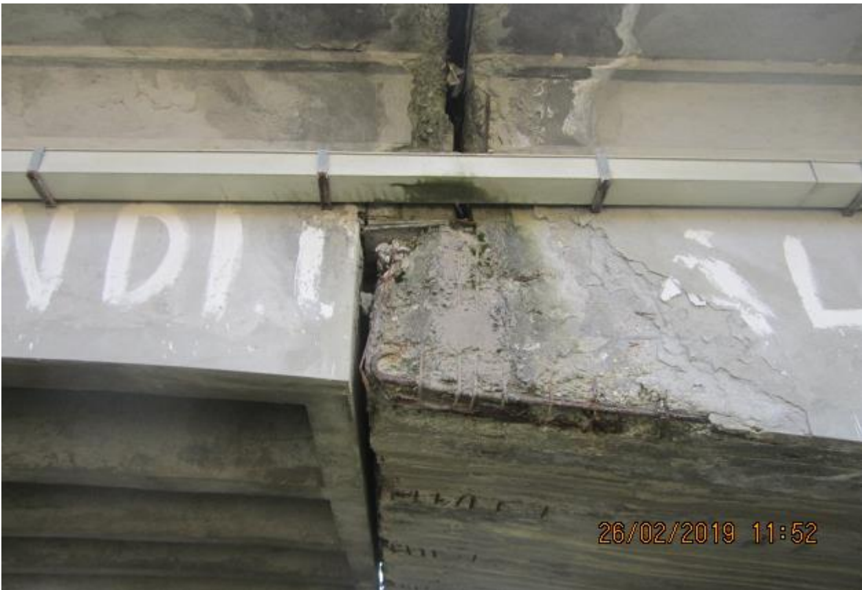
Degrado gerber
