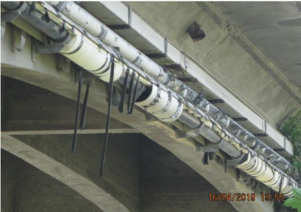
INTERFERENZE ACQUA,GAS,TELECOM LATO VALLE
