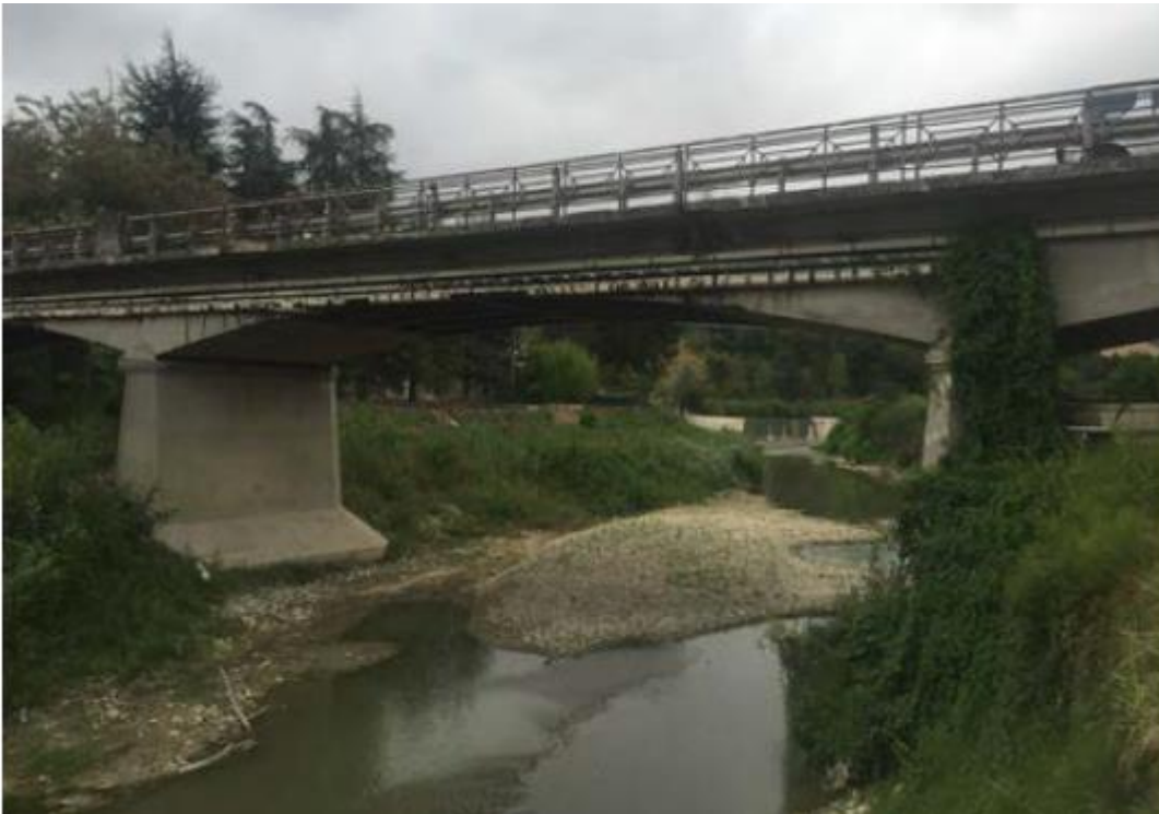
CAMPATA 3 (sul Senio ) vista da VALLE
