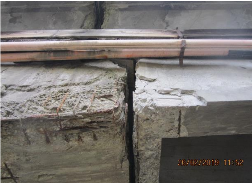
Degrado gerber
