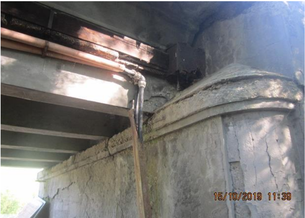
SPALLA SX LATO MONTE
